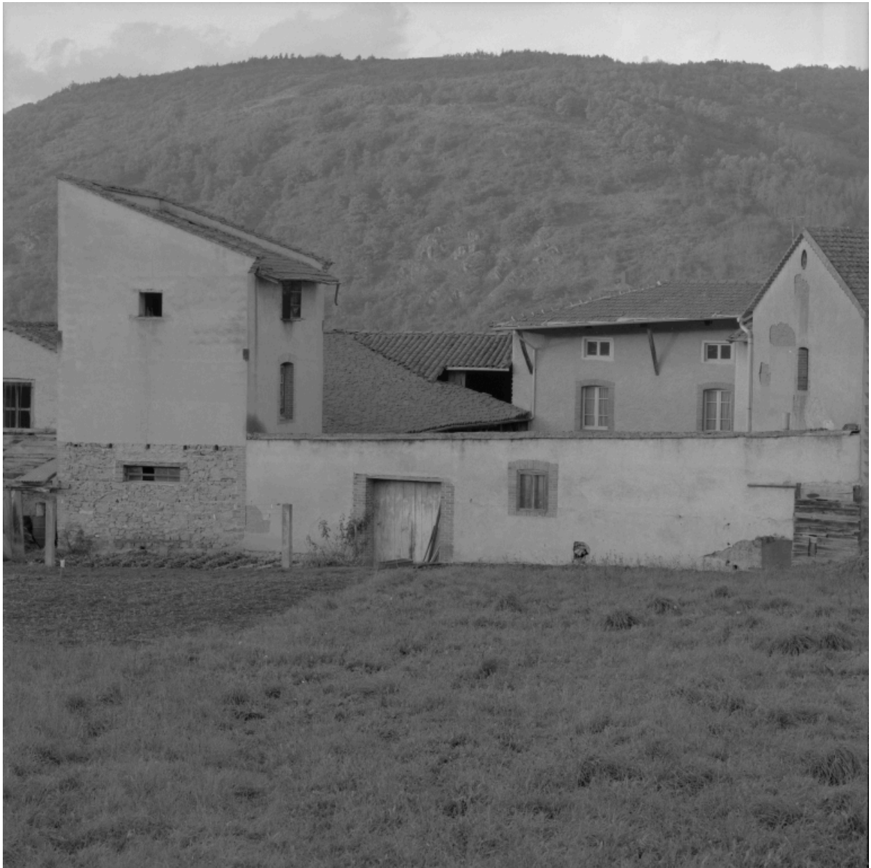
Leigneux, le bourg (1987 A2 926), type B2. Vue d'ensemble depuis l'arrière.
