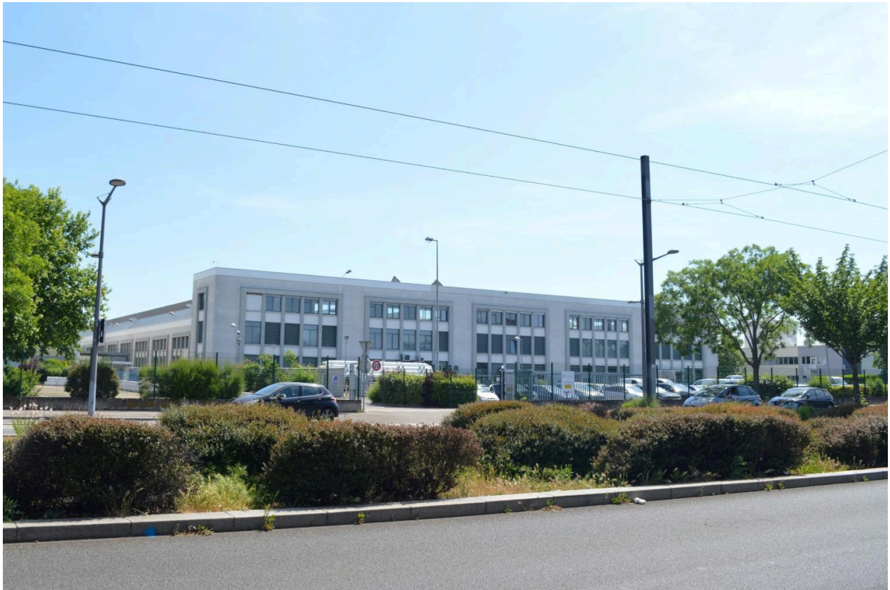
Symbio-Usine de Vénissieux - Ancienne usine S.I.G.M.A. - vue depuis le Boulevard Irène Joliot Curie - mai 2022
