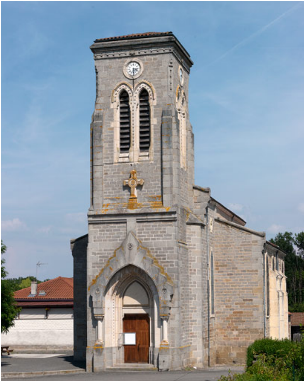
Vue d'ensemble de trois-quarts depuis le sud-ouest.
