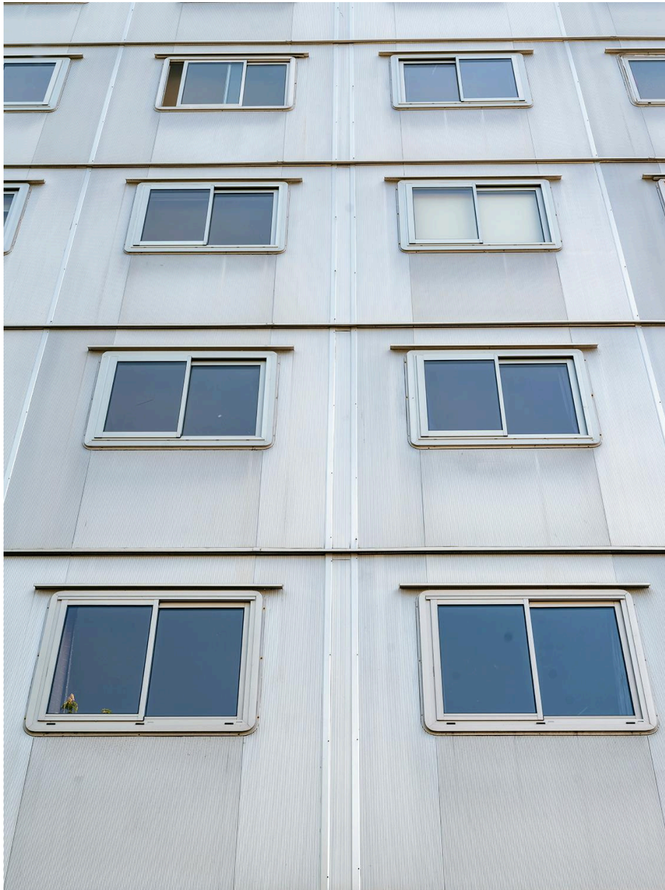
Façade nord de l'immeuble des Cèdres
