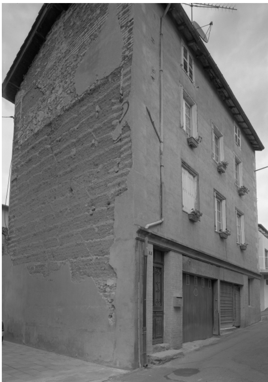
Vue générale de la maison située au 6 rue Alsace-Lorraine, avec mur pignon en pisé surélevé en moellons, de l'ouest.
