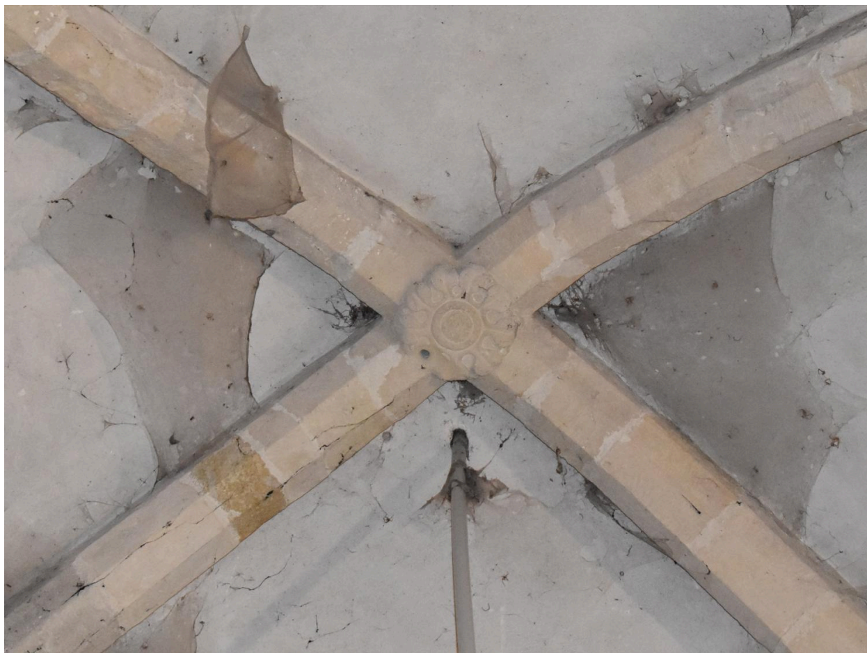
Détail de la croisée d'ogives à clef de voûte ornée d'une rosace de la travée d'avant chœur.
