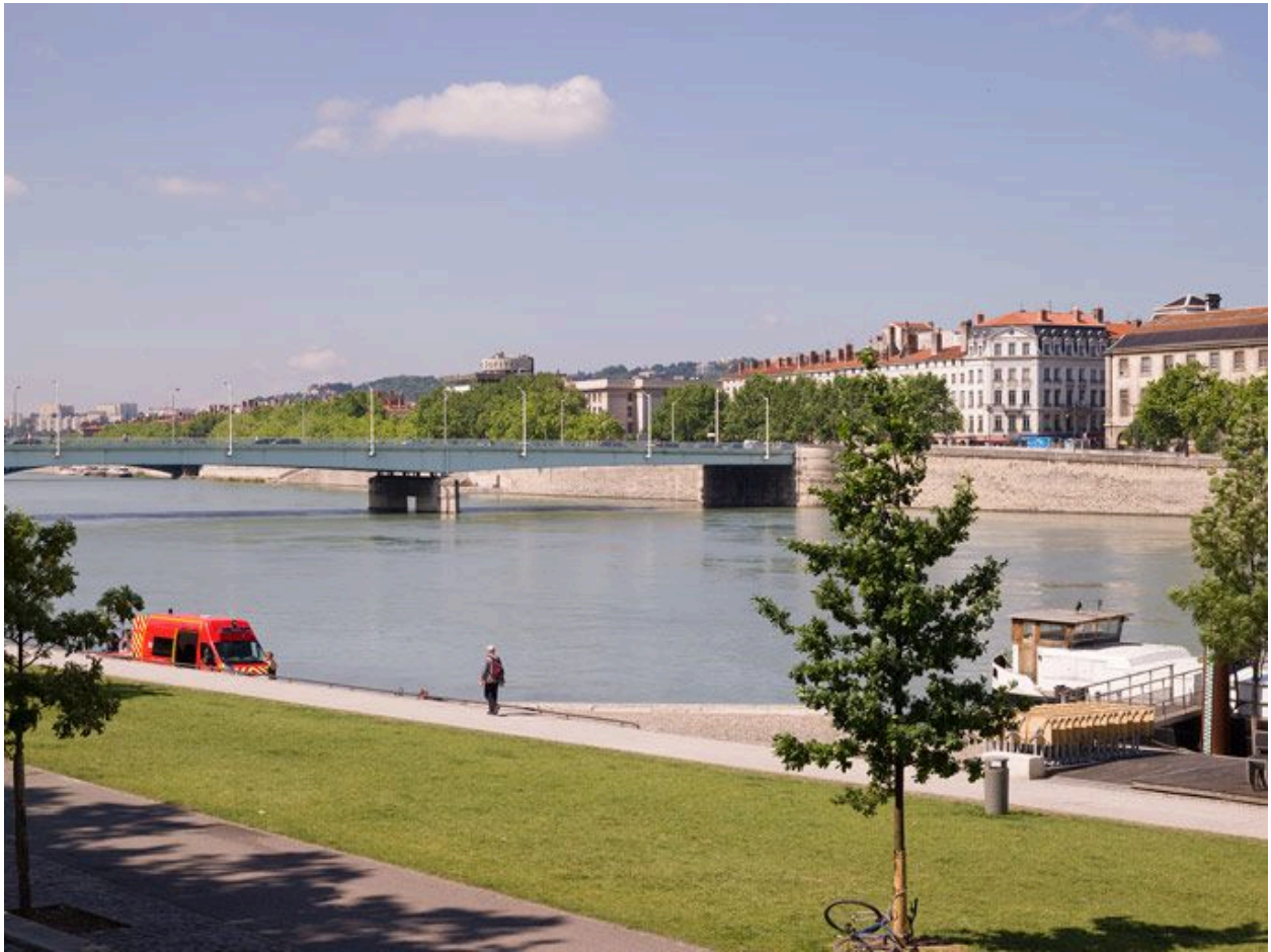
Le pont depuis le nord-est et son débouché rive droite
