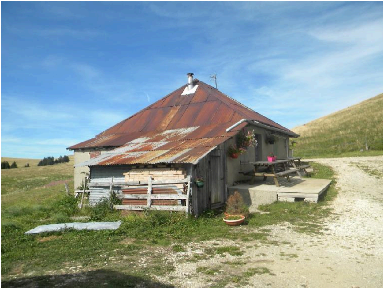
Vue de trois-quarts sud-ouest du bâtiment d'habitation.
