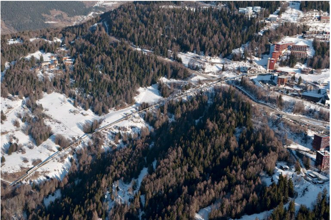
Vue aérienne de la ligne du funiculaire Arc-en-Ciel depuis le sud-ouest
