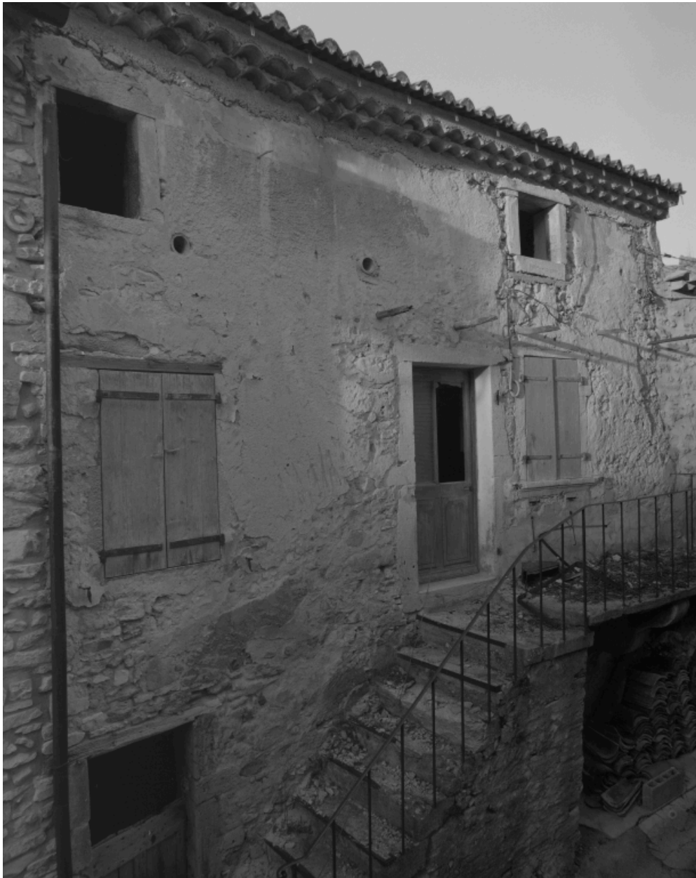
Le Pègue, rue de la Bourgade. Maison (B3 620), vue partielle de l'élévation.
