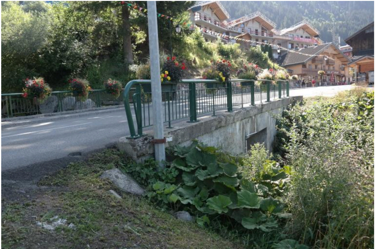
Vue générale du pont de Fiolle
