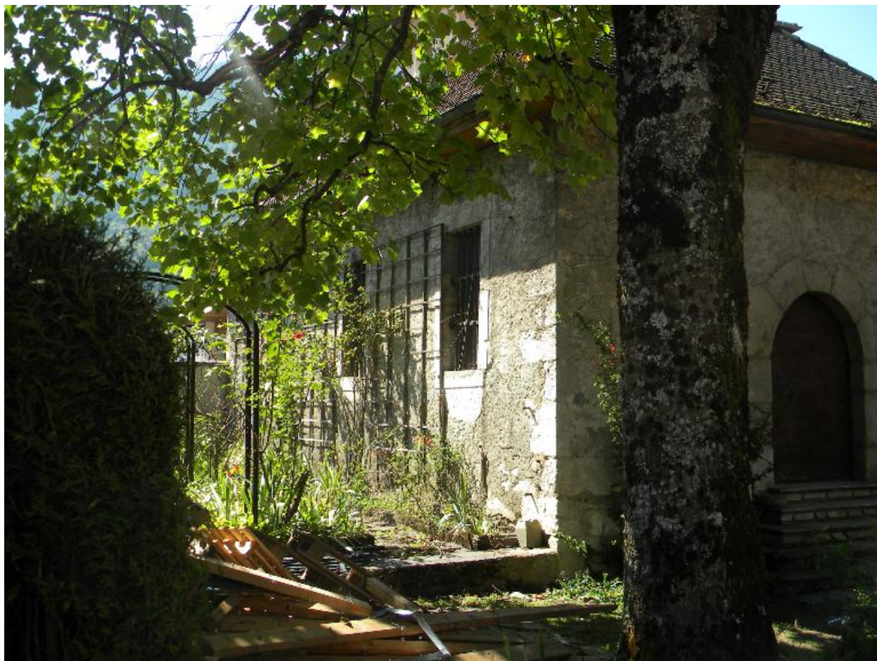
Vue de trois-quarts d'un bâtiment ancien rue Asghil Favre (2008 D7 3171).
