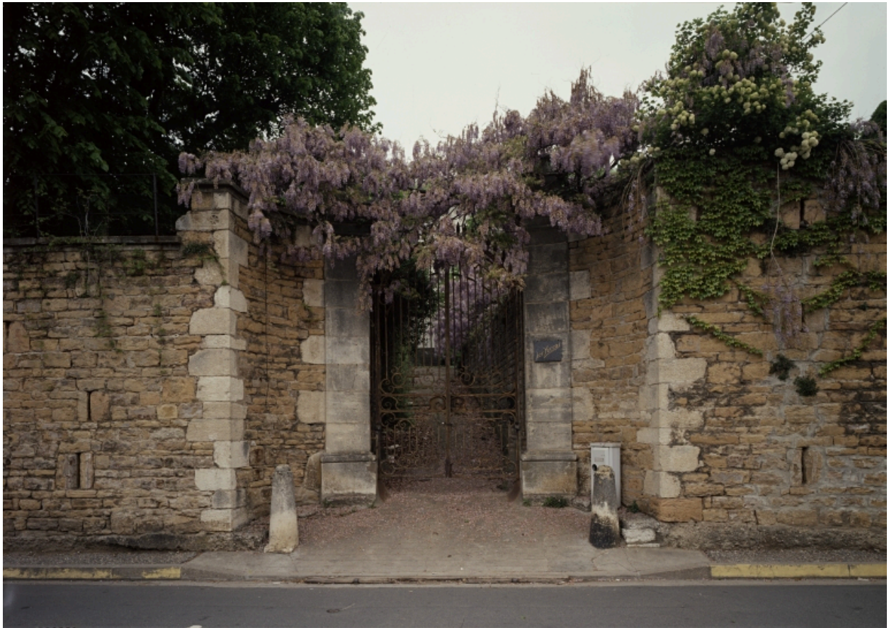
Maison de notable (type VII), dite Les Yuccas, 10 boulevard de l'Industrie : portail sur rue daté [1818] (détruit après inventaire).
