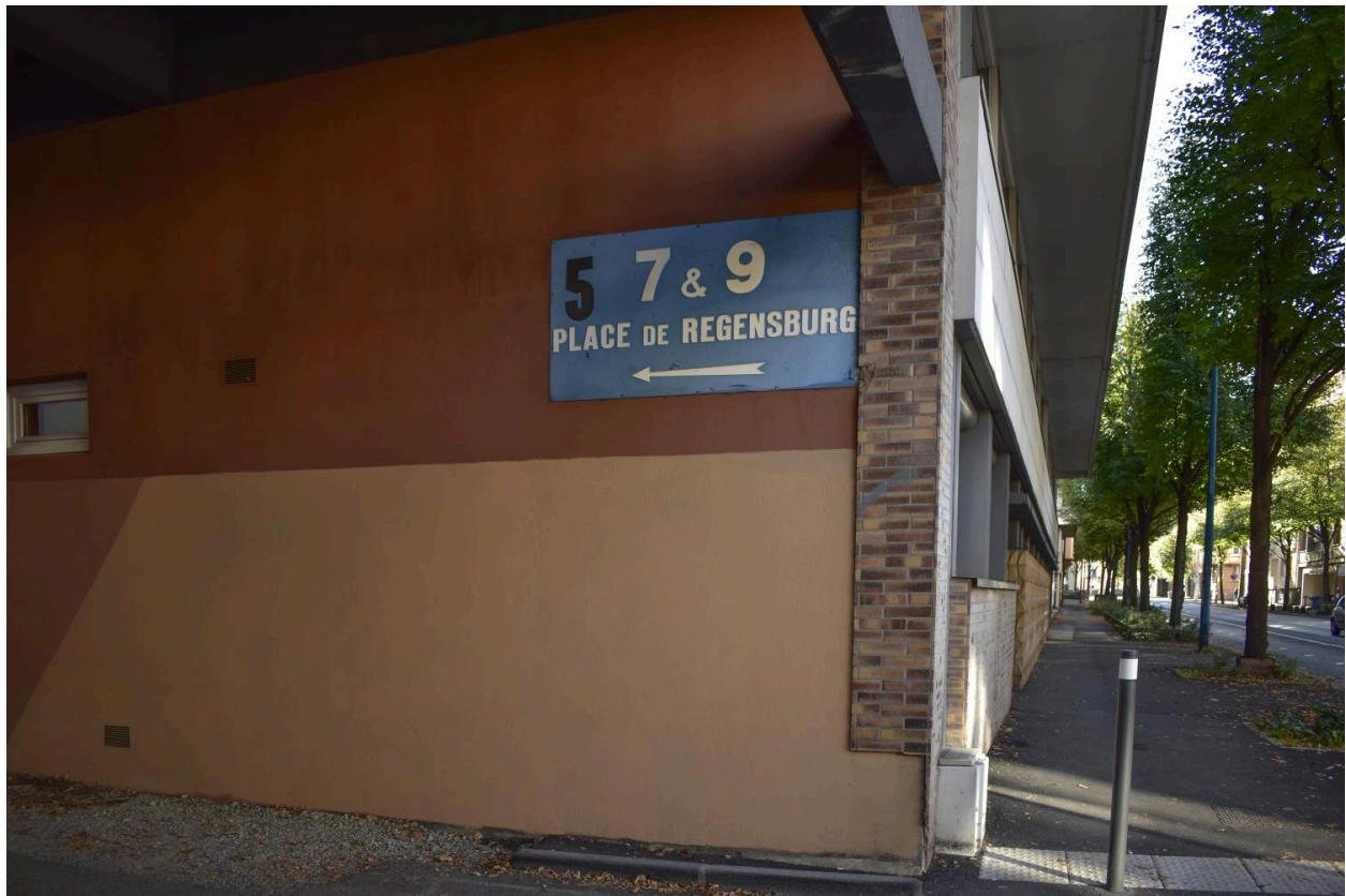
Passage en rez-de-chaussée menant du boulevard Aristide-Briand à la place de Regensburg
