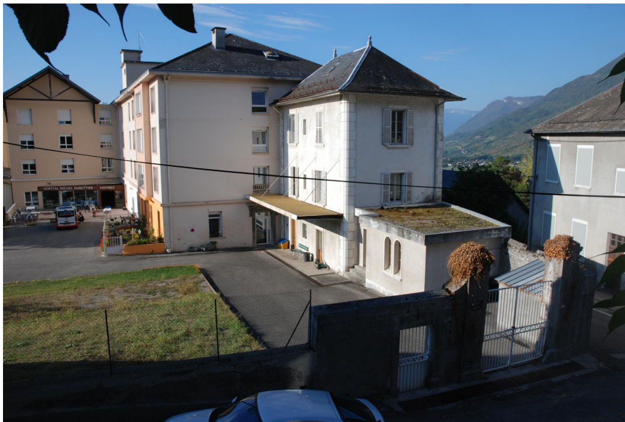
Bâtiment ouest, vu depuis le nord.
