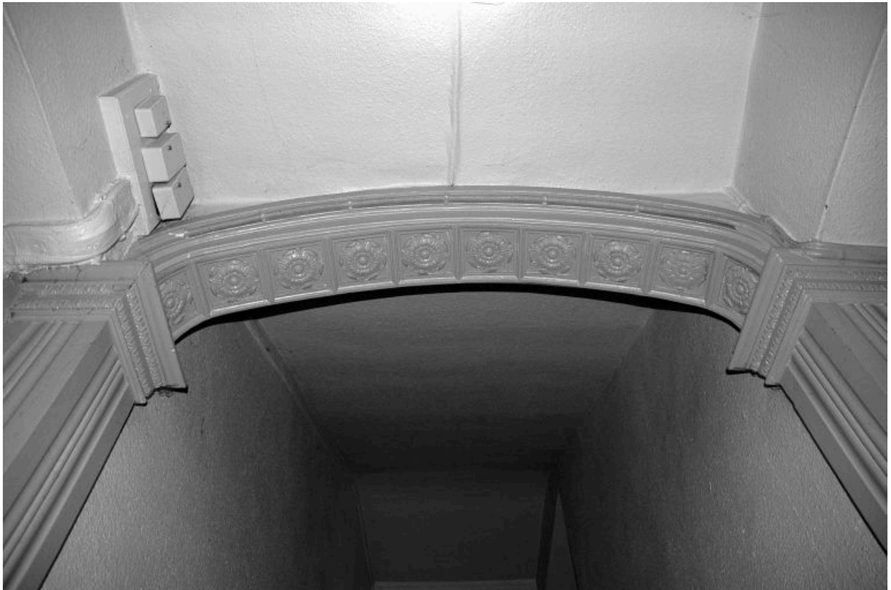
Arc en anse de panier dans le vestibule d'entrée.
