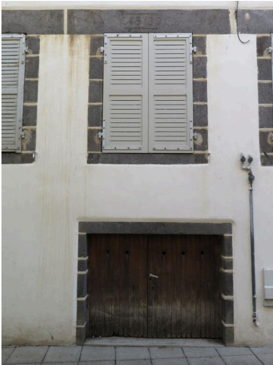
Un des accès au chai et fenêtre
