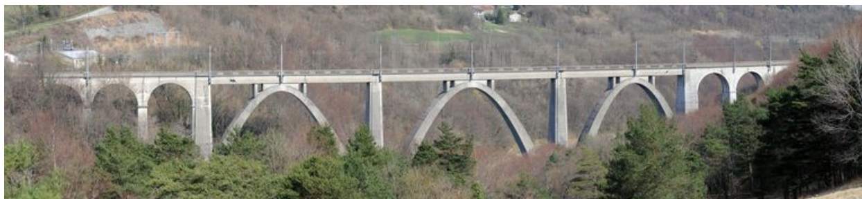
Vue panoramique, côté aval
