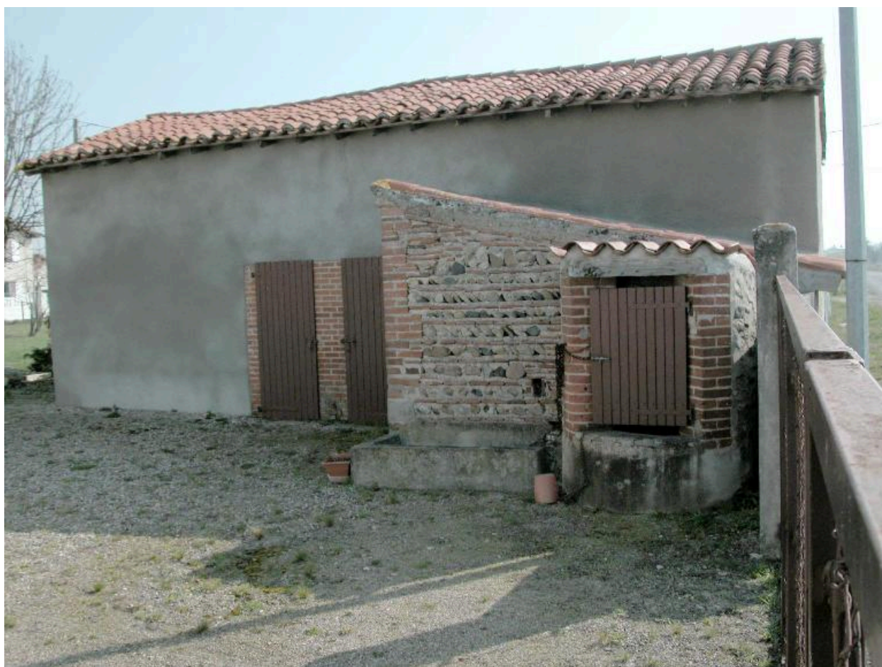
Vue d'ensemble du puits et des bâtiments arrières.
