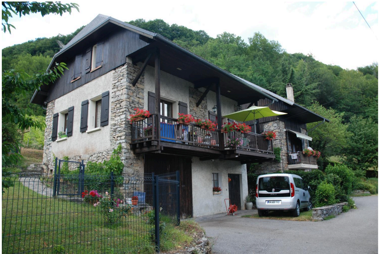
Granges-étables transformées en habitations (2018 E3 698, 694).
