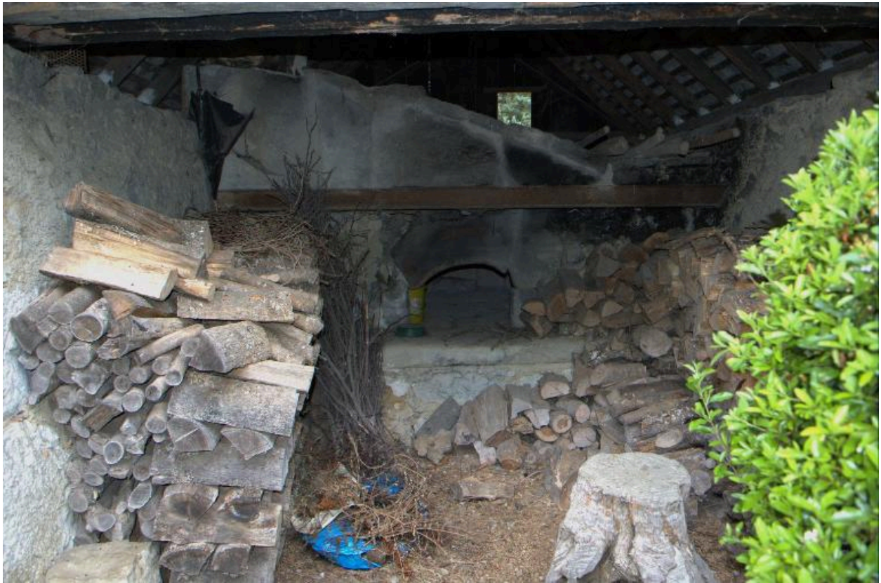
Vue d'ensemble intérieure du four à pain.
