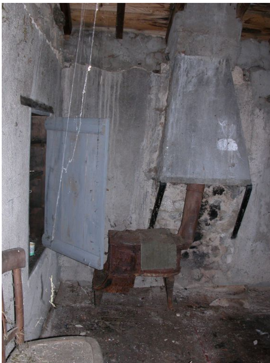
Vue intérieure de la loge, étage carré.
