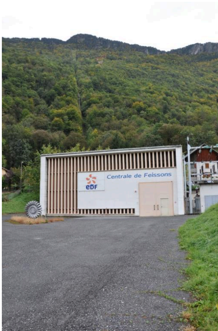
Vue de la centrale de Feissons depuis la route nationale n°90.
