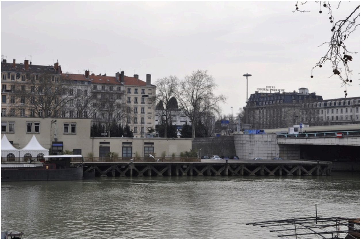
Estacade : vue ouest
