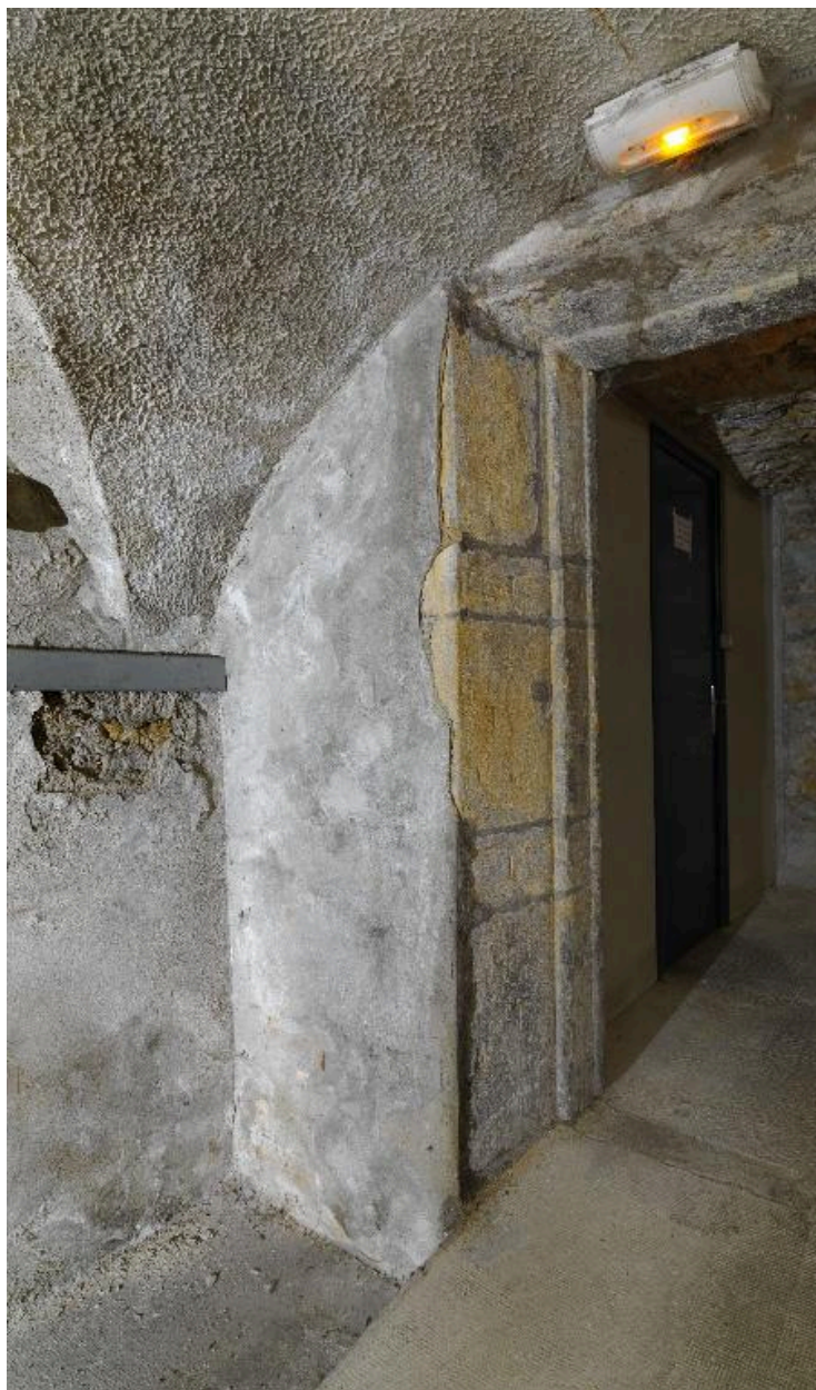
Porte de communication entre le soubassement de la galerie nord du cloître et l'escalier droit
