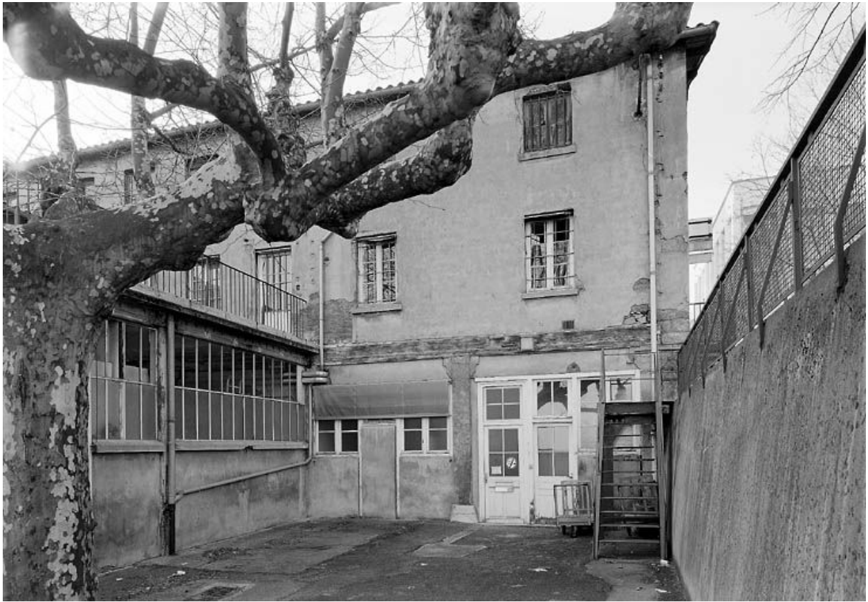
Bâtiment de la Remise (21), façade principale à l'est, détail de la partie droite
