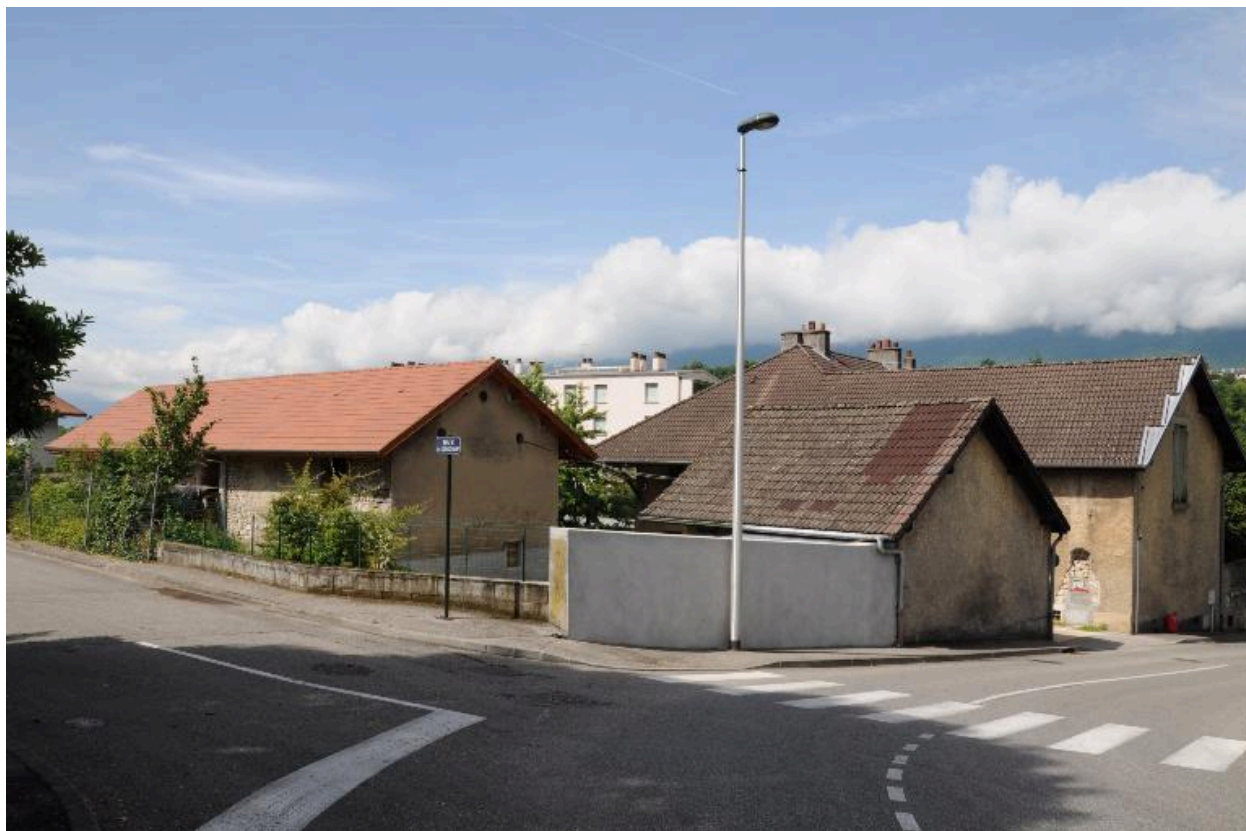
Vue d'ensemble depuis la rue
