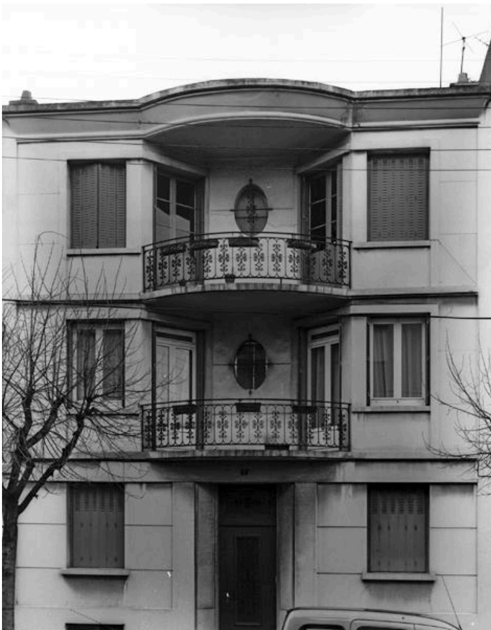
Travée centrale de la façade
