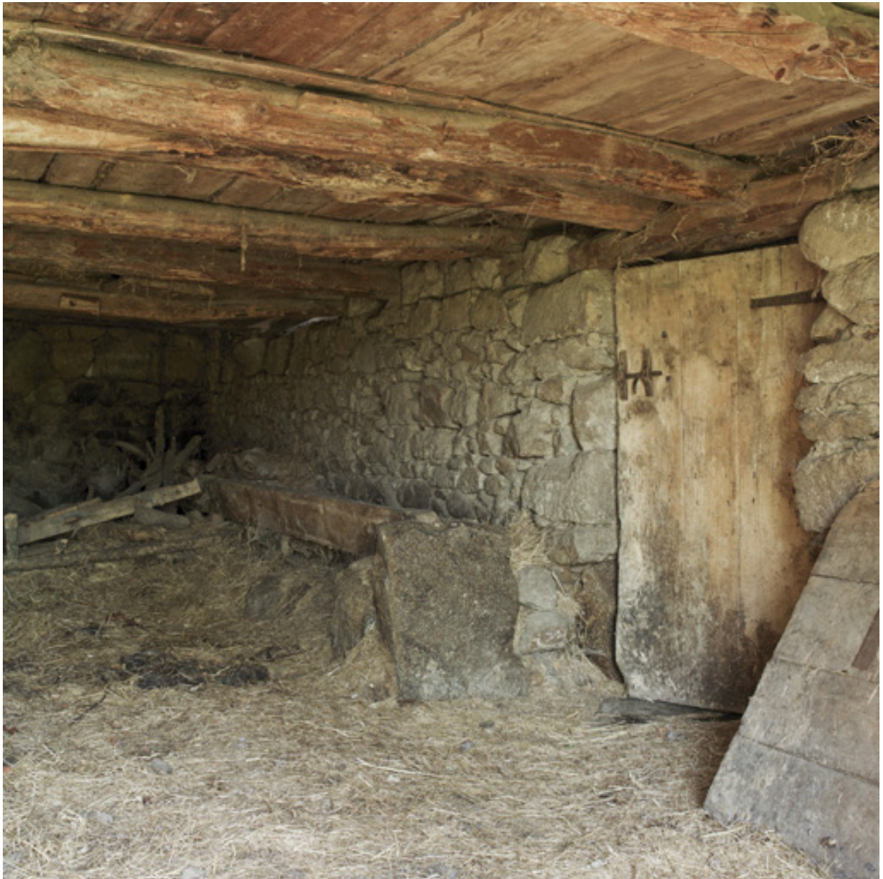
Vue intérieure de l'étable, partie nord (porte de communication avec la grange).
