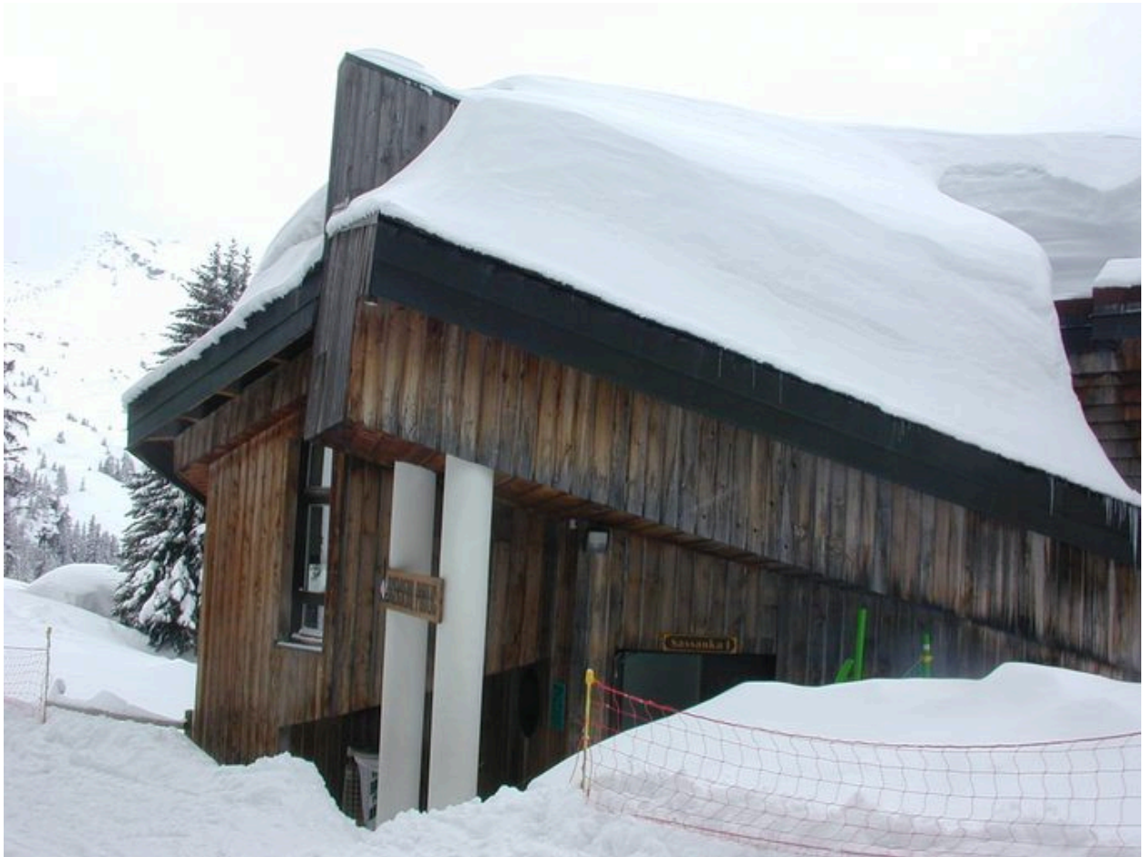
Entrée amont, rue des Ardoisières, accès à la coursière et à l'ascenseur publics
