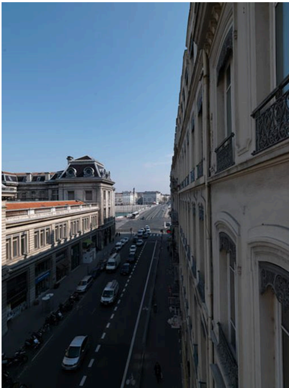
Bâtiment A' et A et la rue de la Barre. Vue depuis l'ouest
