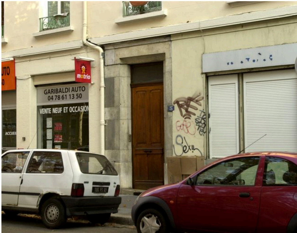
Élévation principale. Détail de l'entrée
