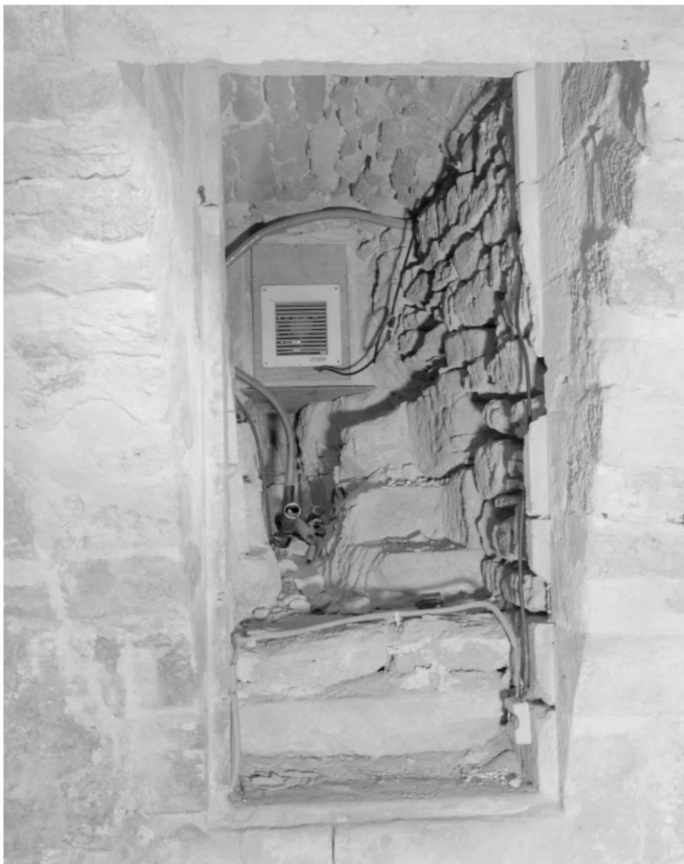
Grande cave. Vestiges d'une fenêtre à degré à l'angle nord-est.
