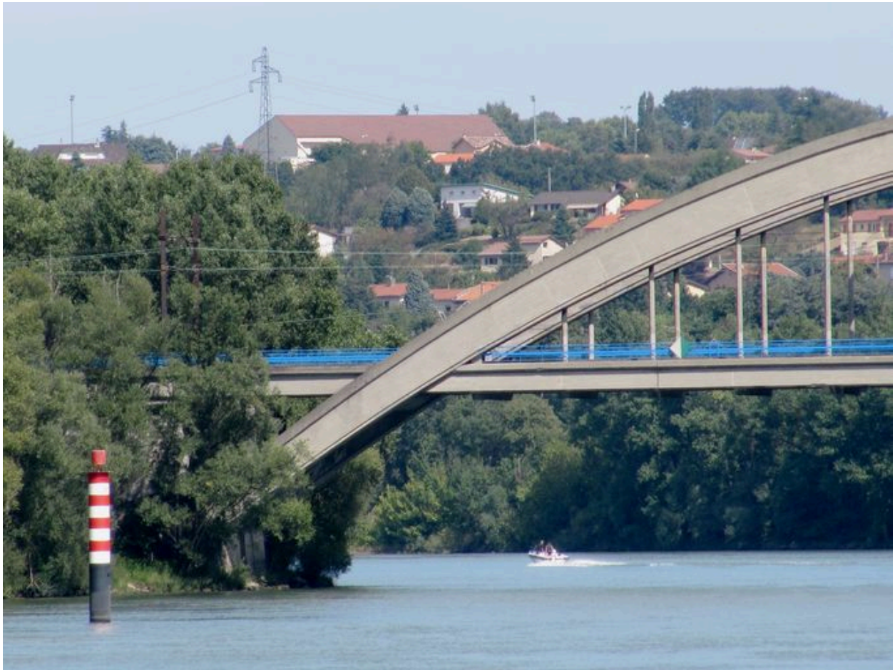
Vue partielle, rive droite, face aval
