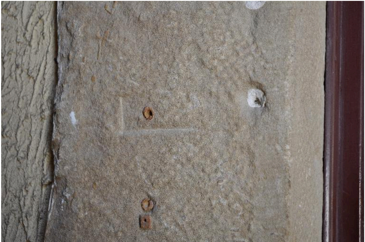
Vue intérieure : marque de tâcheron sur l'encadrement d'une porte palière
