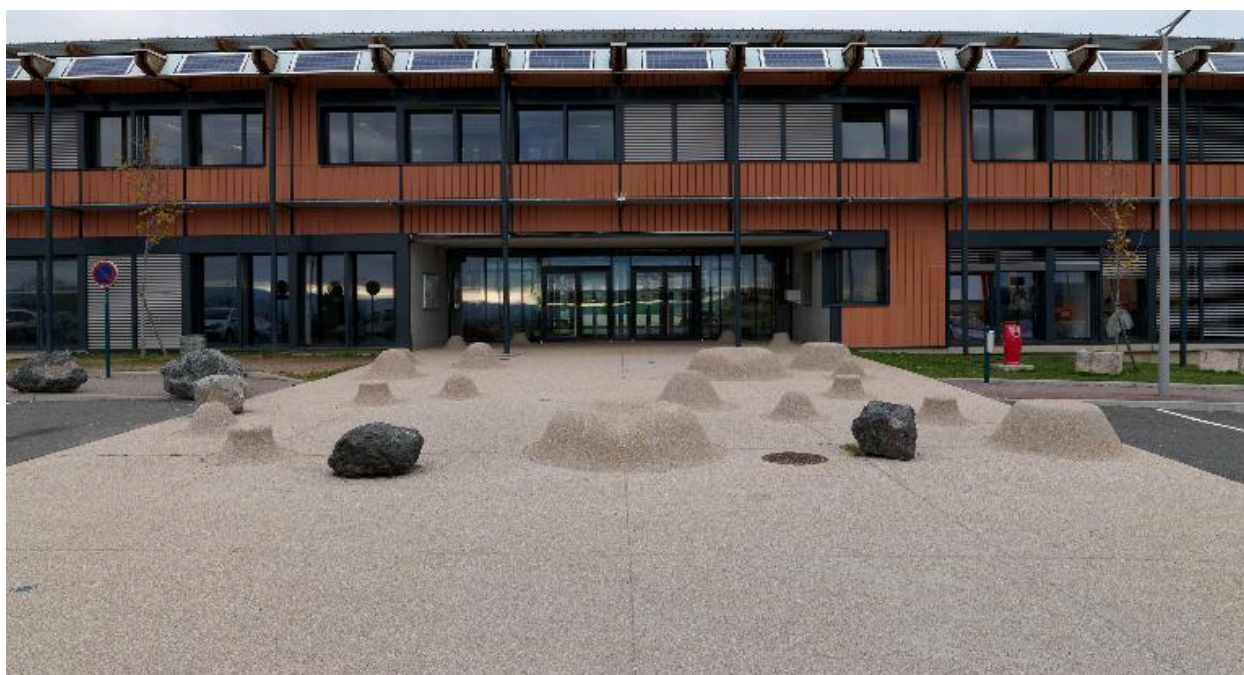
Vue d'ensemble de la partie extérieure, en 2015
