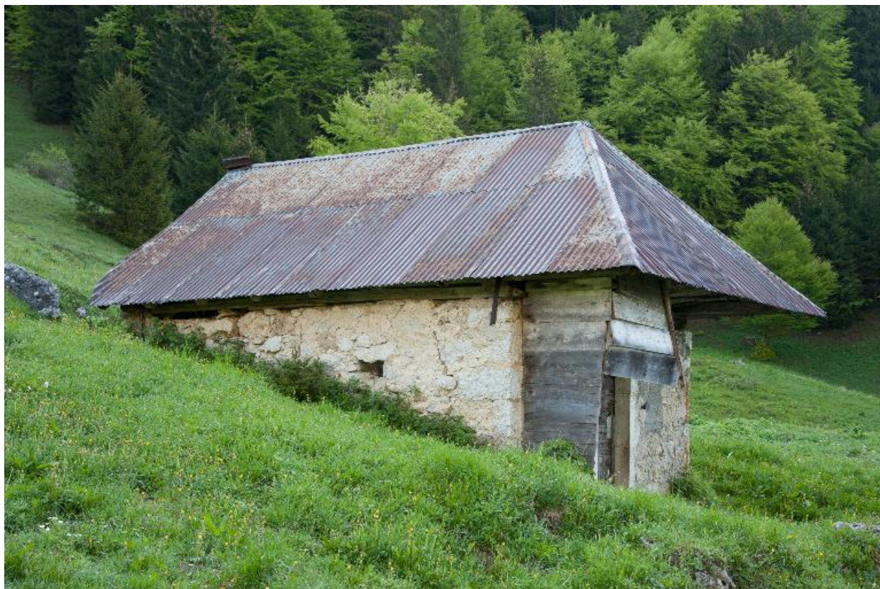
Vue du bâtiment de la cave.
