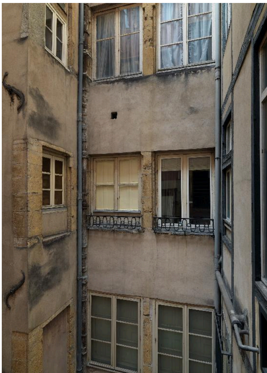
Corps de bâtiment sur cour : les étages carrés, vue partielle
