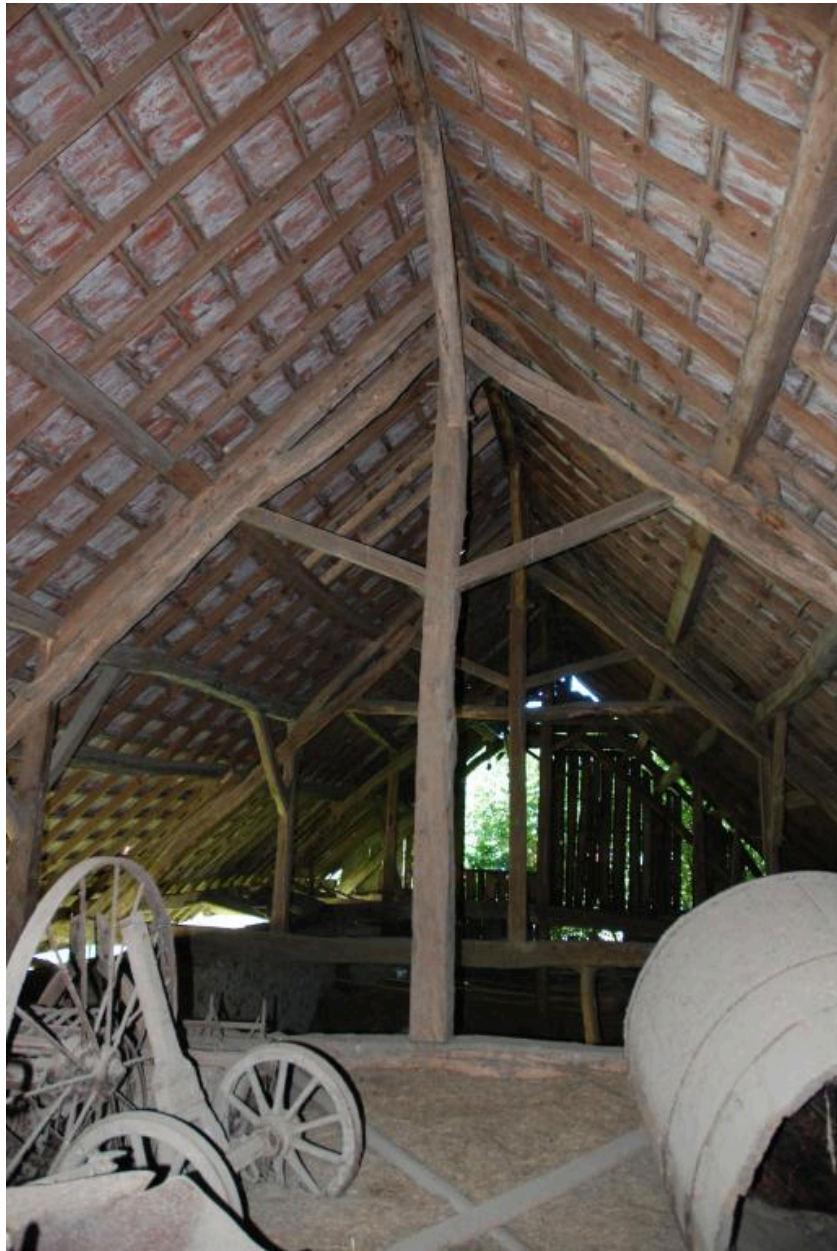
Vue intérieure du comble, depuis l'est.
