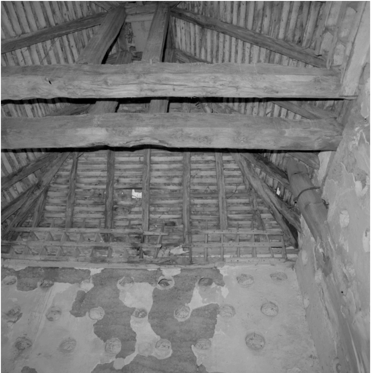
Vue intérieure de la charpente et des boulins aménagés dans la partie supérieure du mur.
