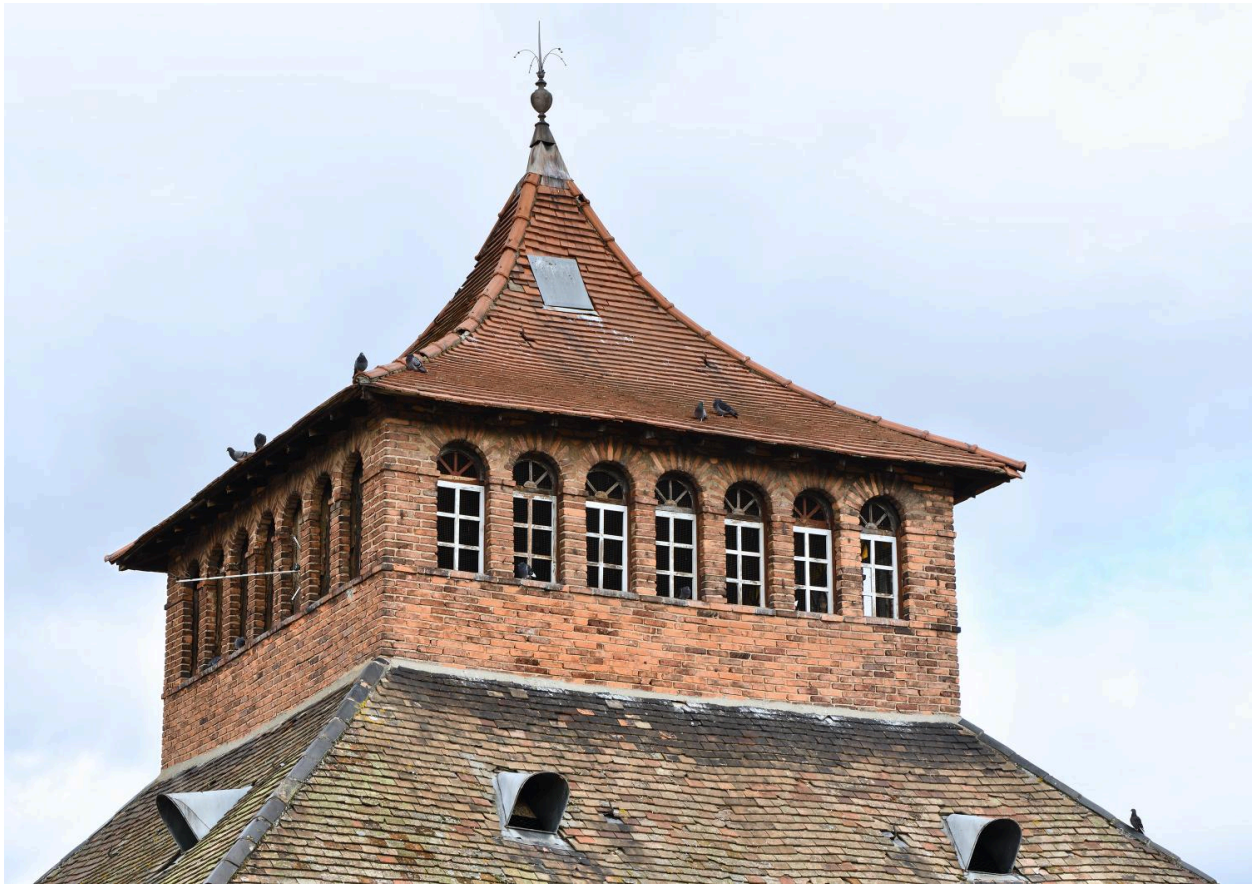
Lanternon ou lanterneau du séchoir
