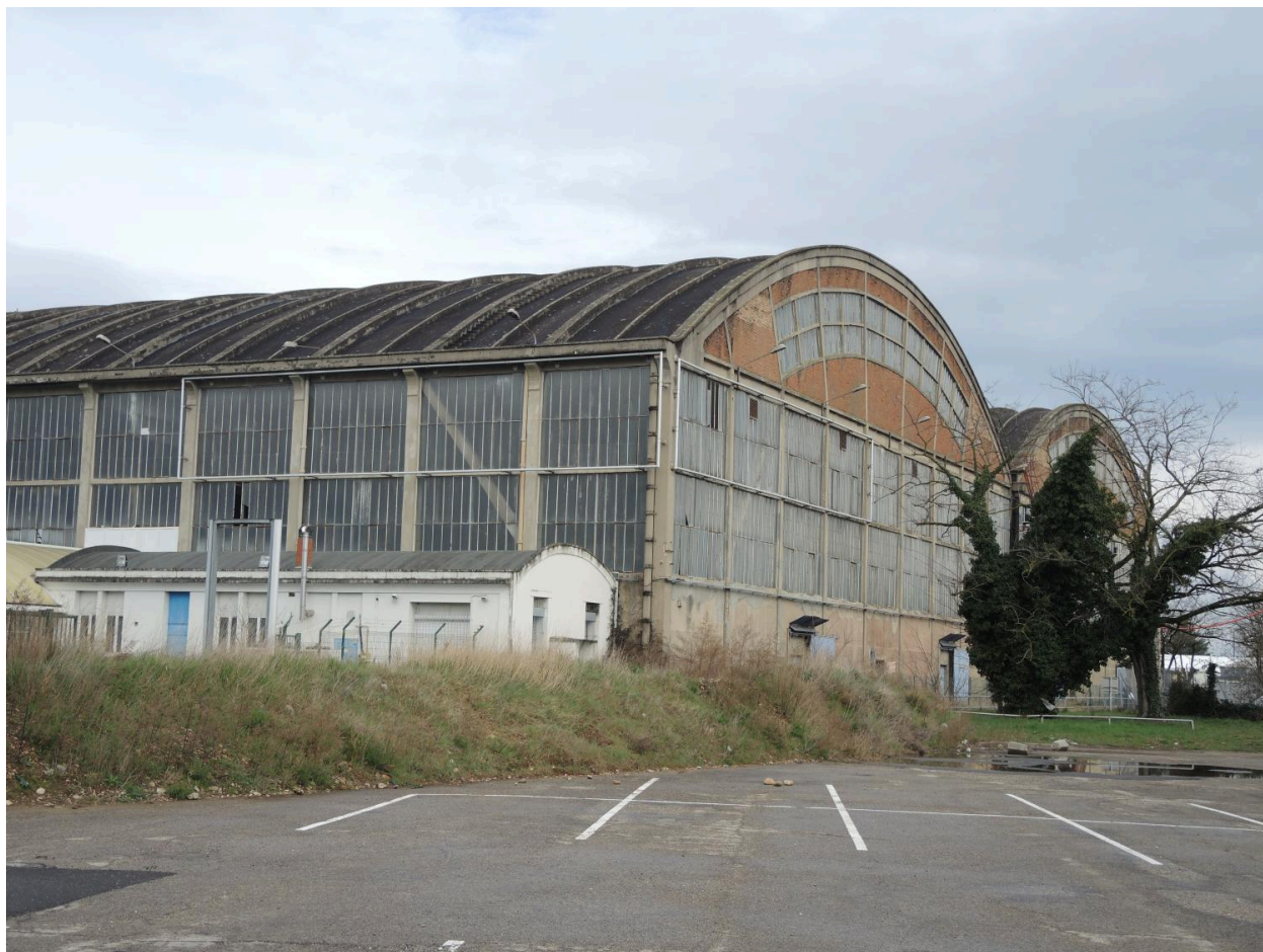
Hangar VI photo vue d'extérieur
