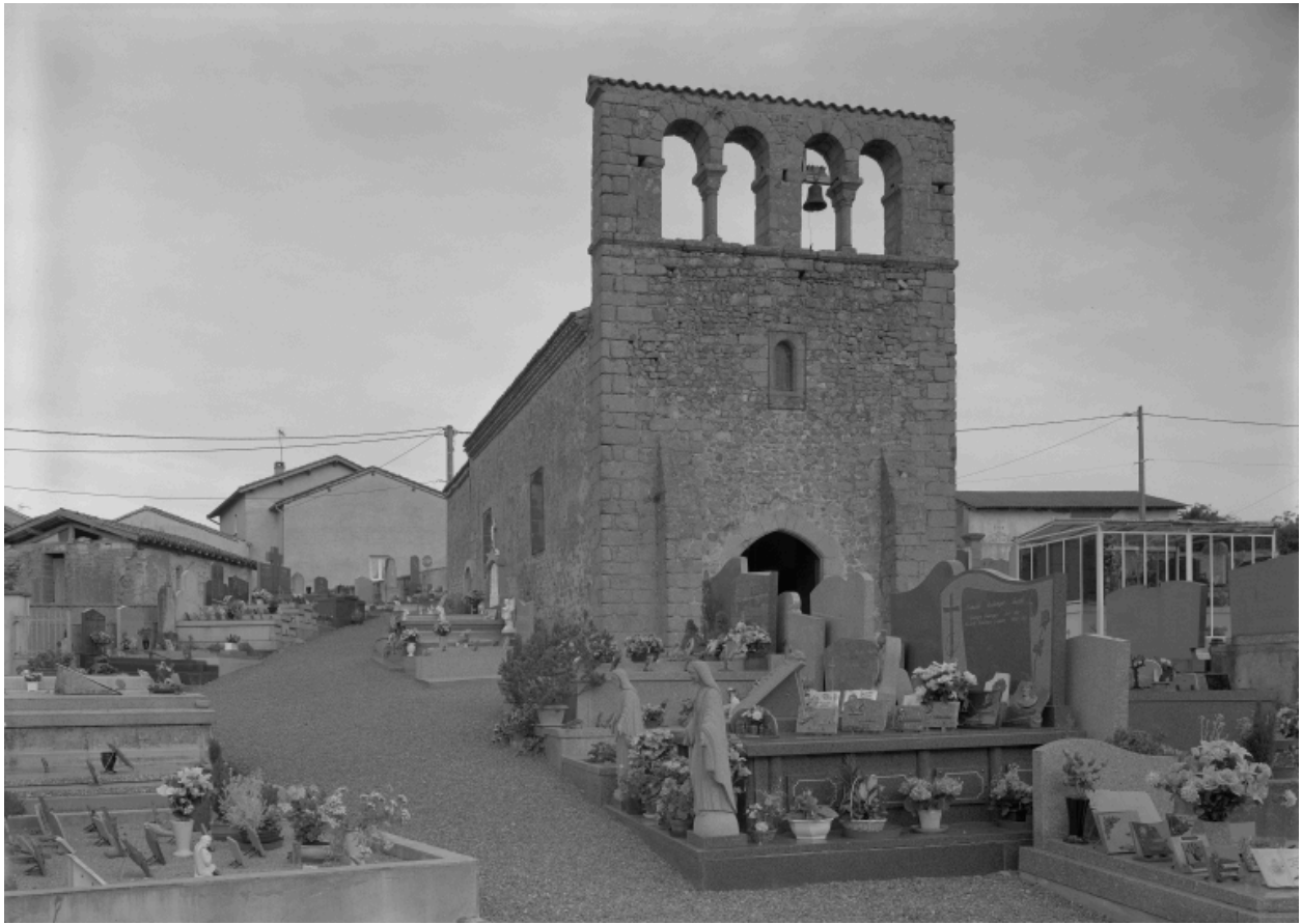
Vue générale de trois-quarts, depuis le nord-ouest.
