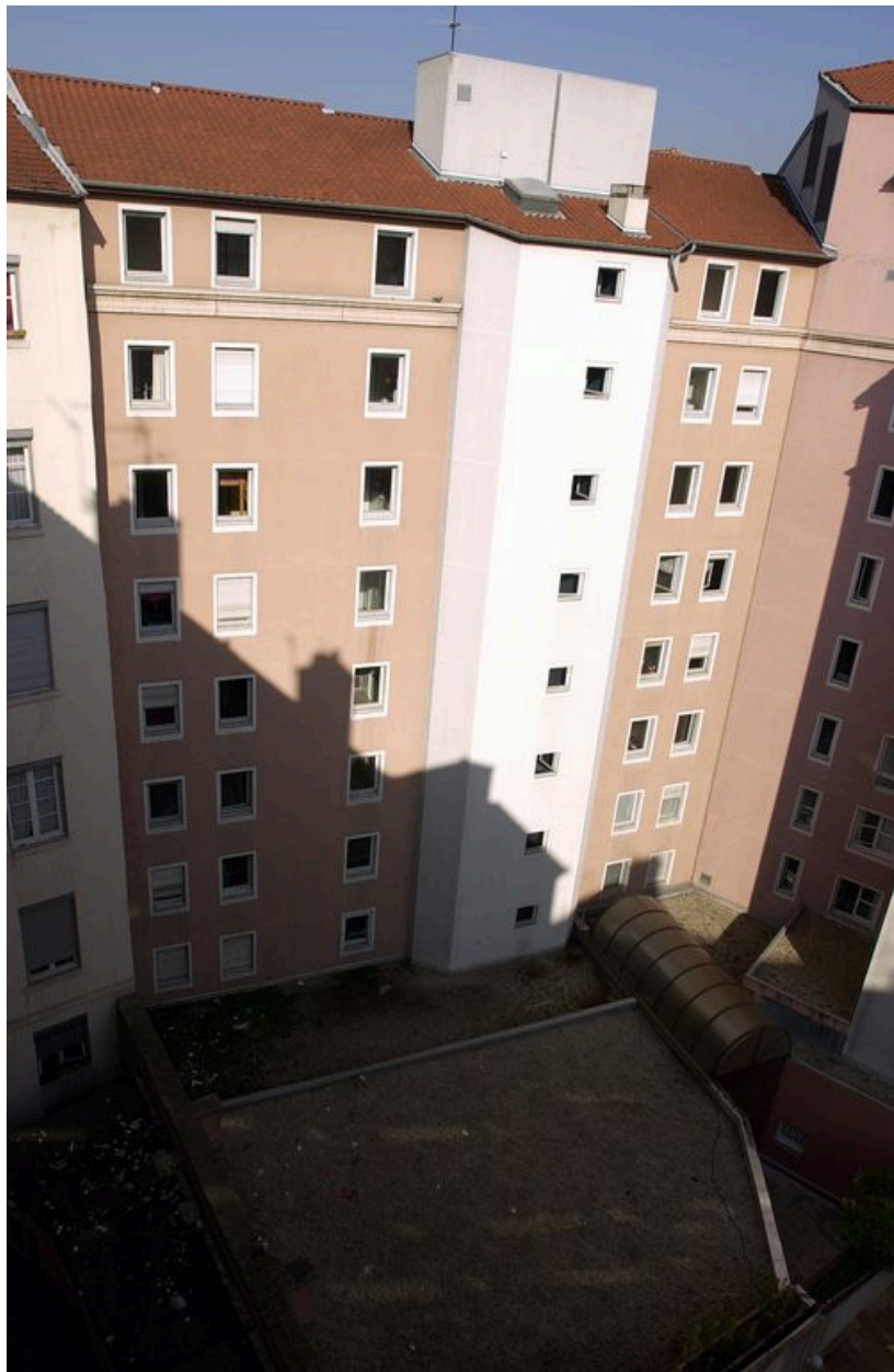
Elévation ouest de la cour fermée
