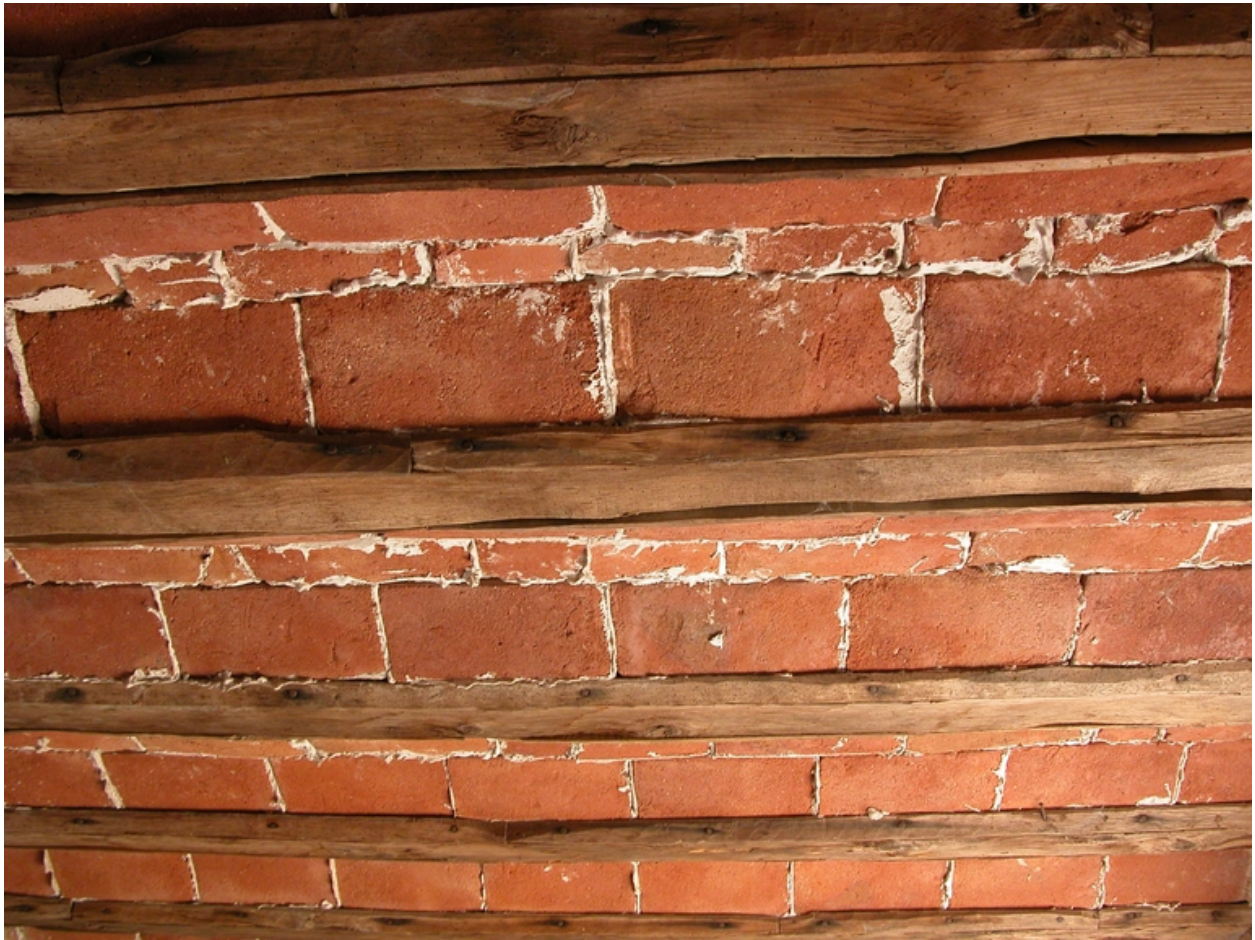
Détail du plafond à voûtaines de brique sur solives de bois.
