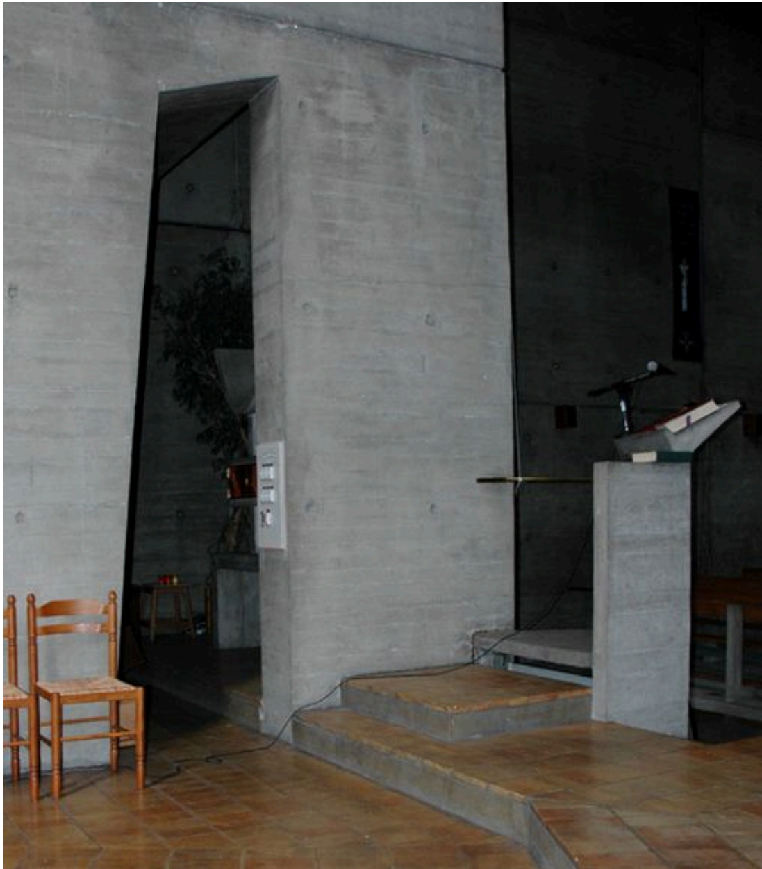
Détail des ouvertures pratiquées dans les murs latéraux du chœur
