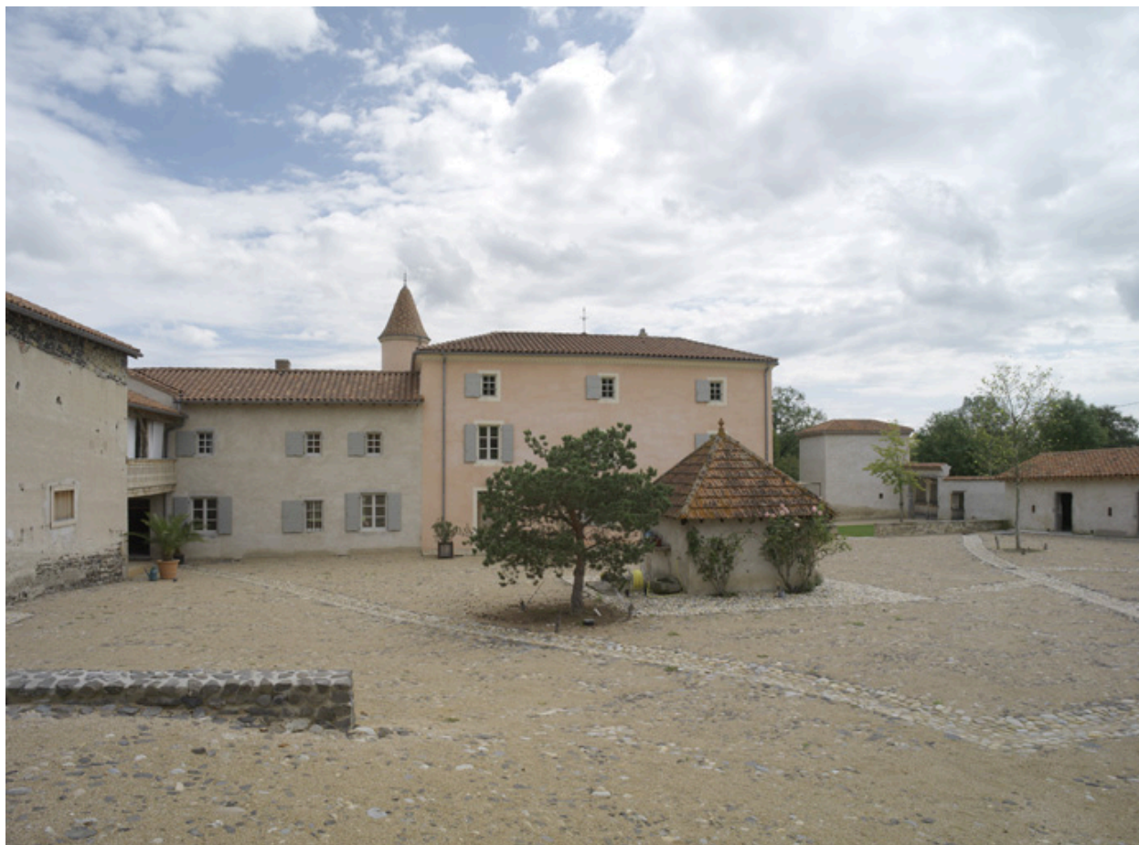
Vue d'ensemble du côté est de la cour.
