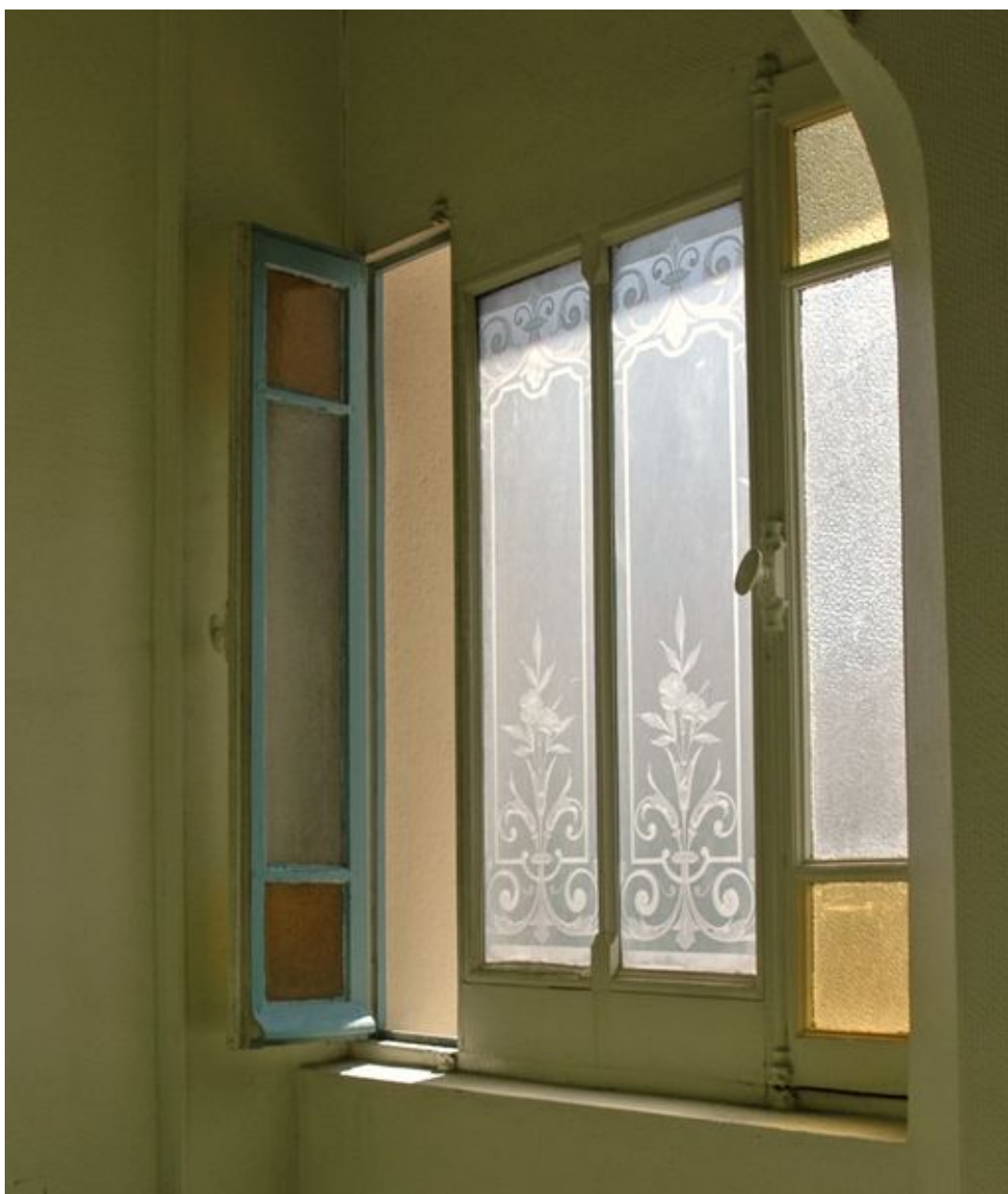
Fenêtre du palier du 3e étage sur cour, corps de bâtiment ouest
