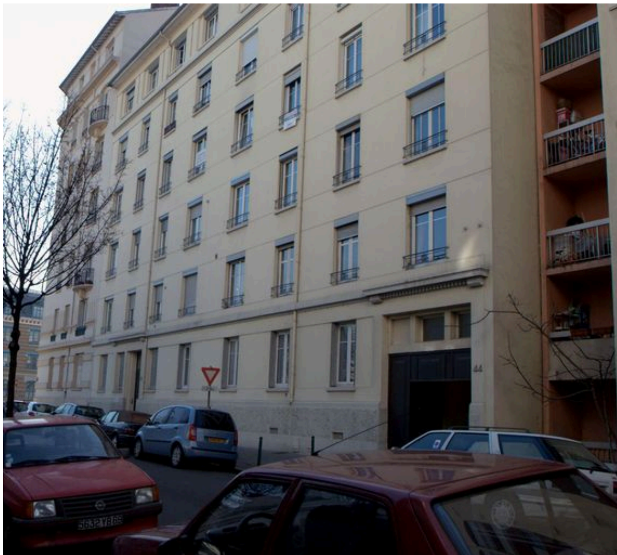
Elévation antérieure, vue partielle
