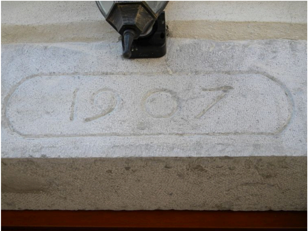
Détail du linteau de porte daté 1907 (B7 1264).
